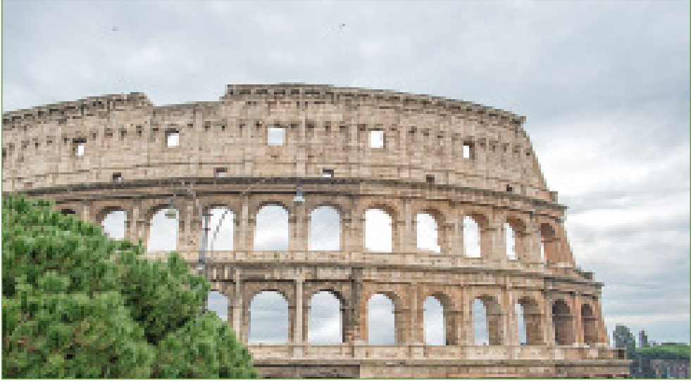
شكل: ١١/٤ مبنى الكلزيوم في روما
